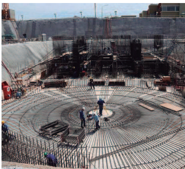
Construcción del Reactor Prototipo CAREM 25
