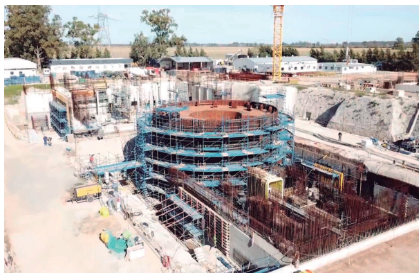
Construcción de la Central Nuclear Prototipo CAREM 25 (Crédito CNEA)
